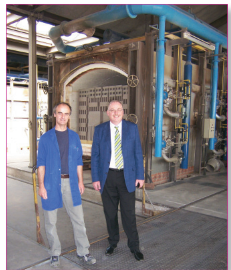
Bild 1: Elektromeister Frank Szczurek (44) und Vertriebsleiter Andreas Strangfeld (48) bei der sicherheitstechnischen Inspektion des Brennofens für Brenntemperaturen von 1000 bis 1400 °C.
