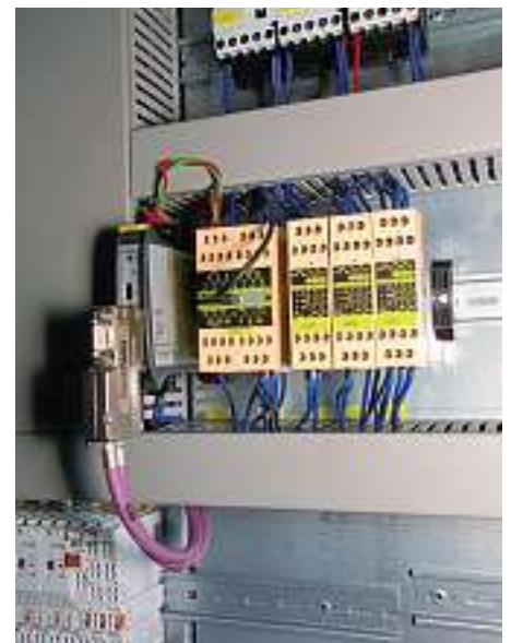
Die Sicherheits-SPS Pluto B20 und B16 vereinfachen den Entwurf von Sicherheitssystemen nach Kategorie 4, EN 954-1
